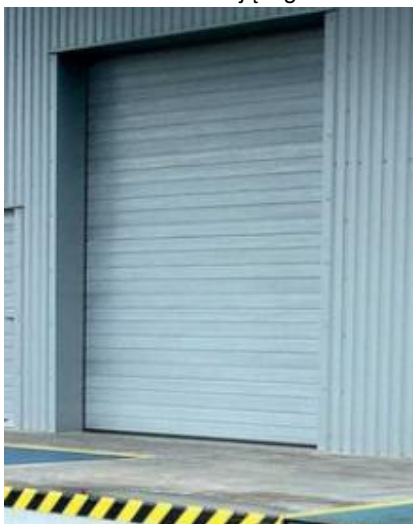
Fotografia 1 Otwarty dok przeładunkowy – bez fartucha uszczelniającego
