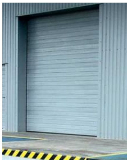
Fotografia 1 Otwarty dok przeładunkowy – bez fartucha uszczelniającego
